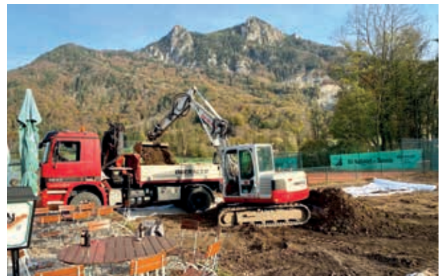
Bau der Bocciabahn
