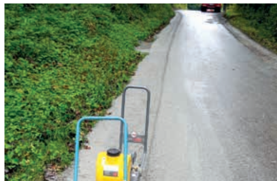
Bankette nach der Sanierung
