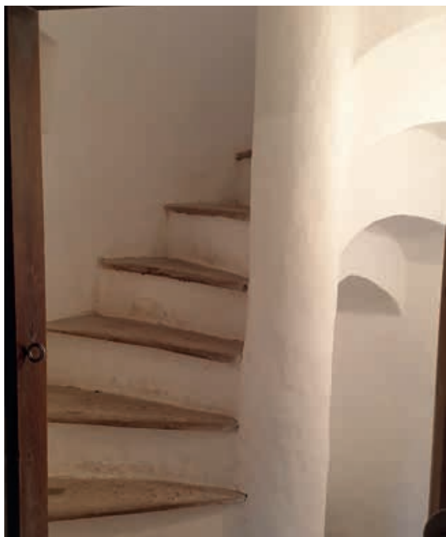
Wendeltreppe mit Lichtnischen
