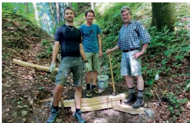
Sanierung der Schwellen (v.l.n.r.): Meinrad Beilhack jun., Markus Gruber und Alois Linder
