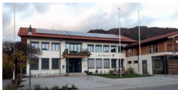
Photovoltaikanlagen auf dem Rathaus
