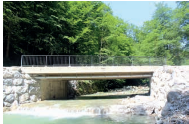
Sappl-Brücke wieder befahrbar
