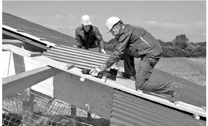
In Gebäuden ohne Geschoss- oder Zwischendecken muss unter der Dachfläche ein Auffangnetz eingespannt werden. Foto: SVLFG
