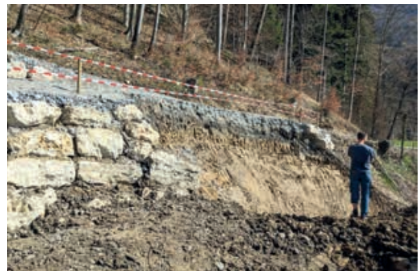
Böschung mit Wasserbausteinen neu aufgebaut
