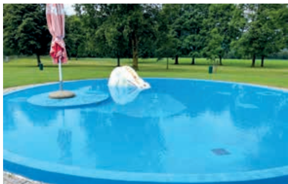
Das Kinderbecken ist saniert
