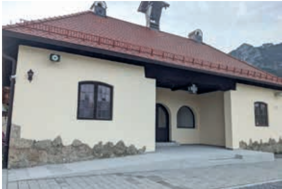
Umbau der Aussegnungshalle fast abgeschlossen
