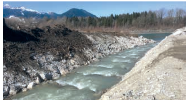
Unterwasseranbindung: Neue Raugerinnerampe an der Steinbachausleitung in den Inn
