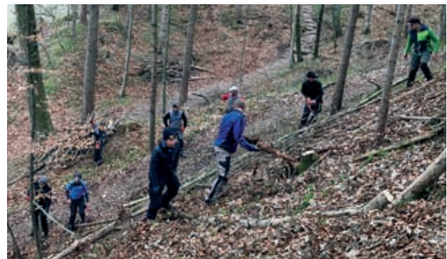
Arbeiten am Kreuzweg
