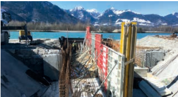
Oberwasseranbindung: Aufstiegsbauwerk zur Anbindung des Inns an den bestehenden Sickergraben
